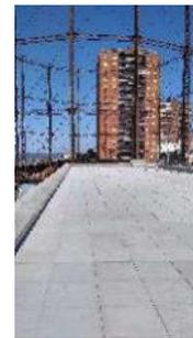
Y la segunda para la protección de la azotea, incorporando una carpeta de arena y portland como terminación de la cubierta para proteger la impermeabilización del edificio de los desprendimientos de lascas metálicas de la estructura del Gasómetro que está fuera de uso y en proceso de degradación; con un área comprendida de 408 m<sup>2</sup>.
