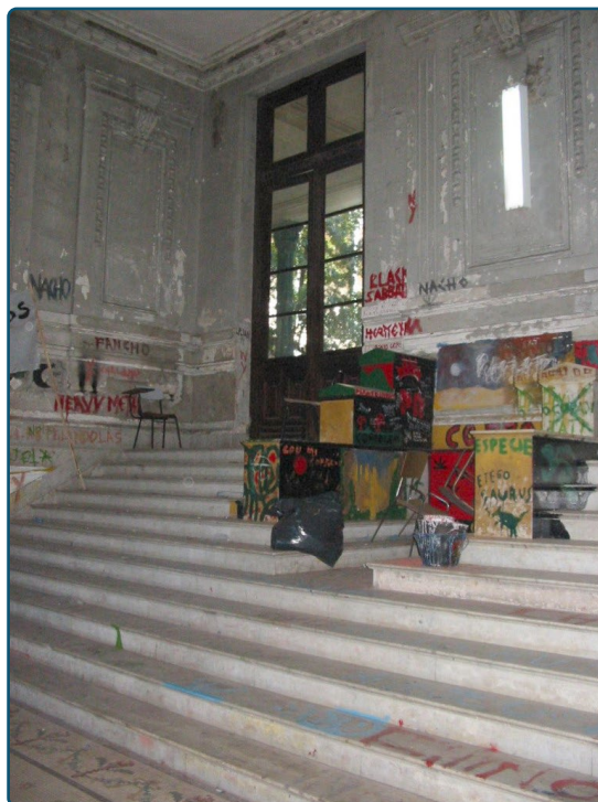
ACCESO RODÓ (ANTES)
